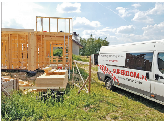
Budowa domu szkieletowego
